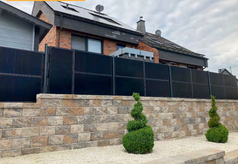
Lärmschutz als Maueraufbau
