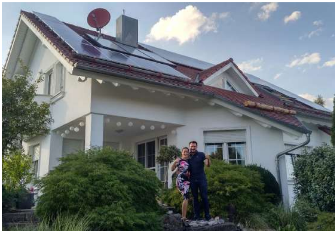
Bild 1: Fertiggestellte Photovoltaikanlage von SolarConsult auf dem Dach von Familie Lisson-Woditsch mit einer Leistung von 9,6 kWp.
